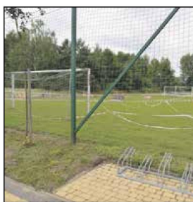
Kompleks sportowo – rekreacyjny w Połaniecu, ul. Krakowska
